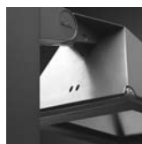
Ojales para evacuación del agua (instalación up y down light)
